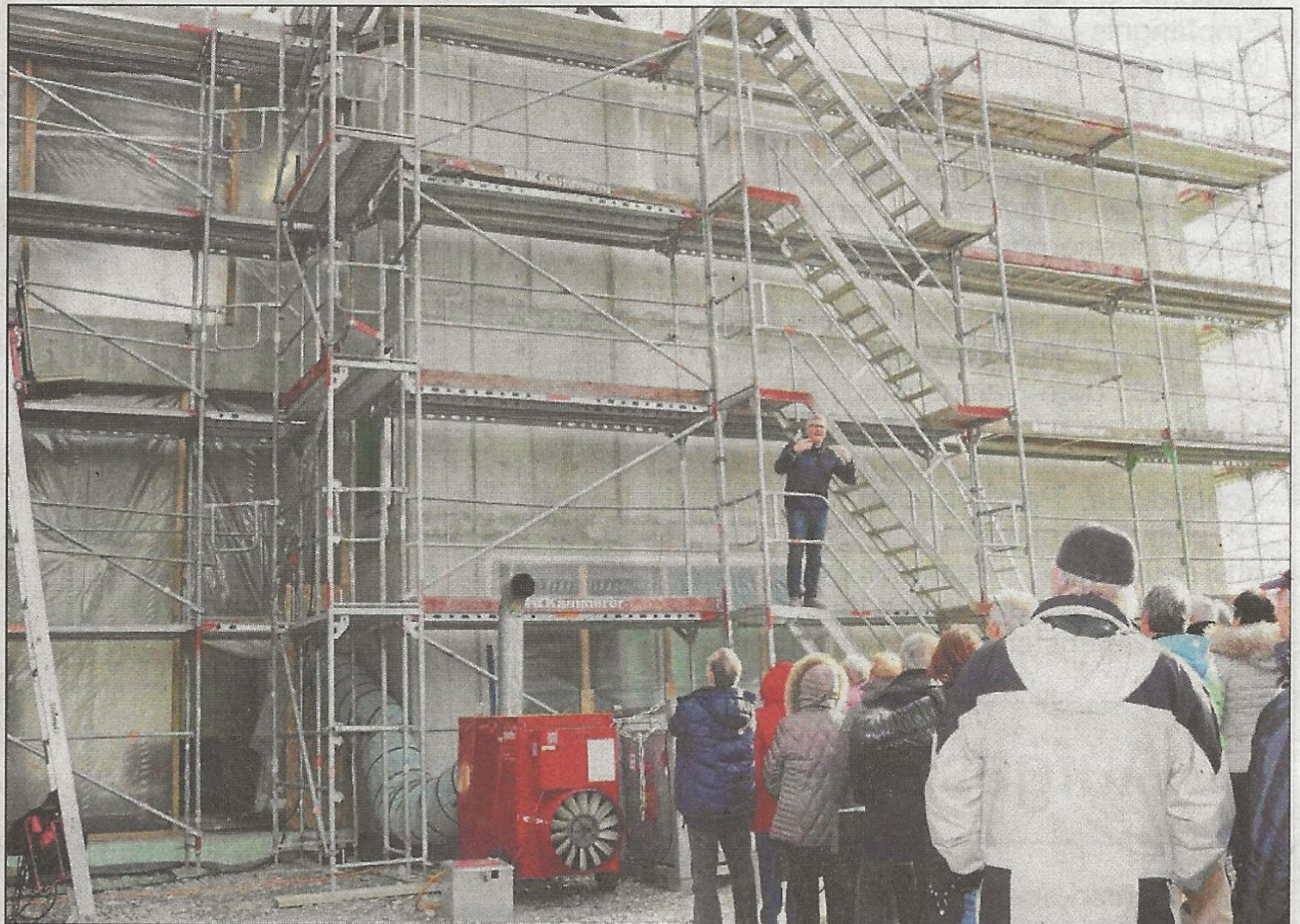
MULTIFUNKTIONALE NUTZUNG: Der Neubau vereint Sportbetrieb und Gastronomie. Vereinsvorsitzender Frank Lautenschläger spricht beim Richtfest. Foto: Lothar
